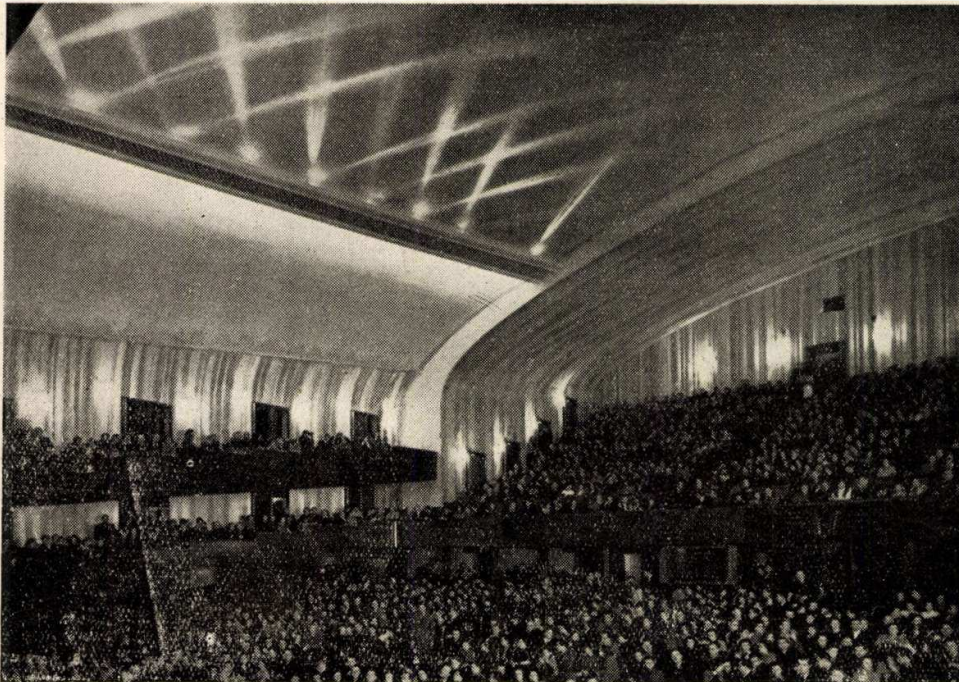
2. ábra. A nézőtér az átépítés után. A diffúz falak az erkélyen és oldalt jól látszanak
