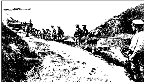
Tengeri kábel fektetése
