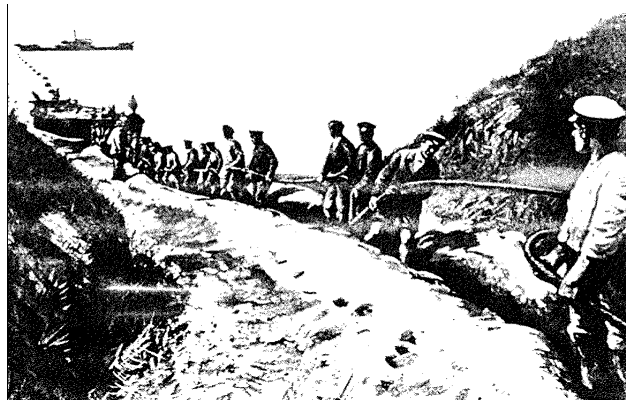
3. kép Egy tengeri telegráf-kábel fektetése [TV] [RM] [KJ] [HJ] [PnL]
