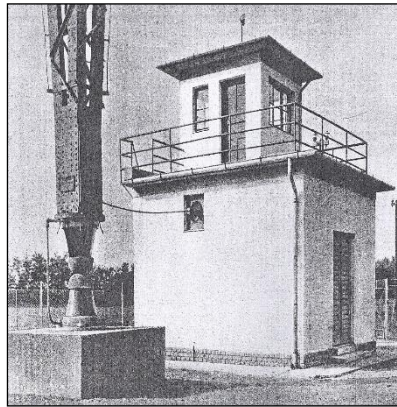
2. kép Az energia betápláló épület és a torony 2000 tonnáját bíró pocellán szigetelői
