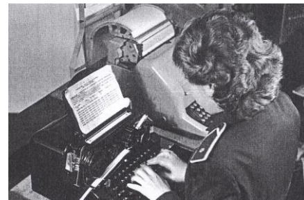
1. kép Táviratírás a T. 68 jelű távgépirón
