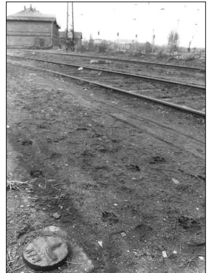
4. kép Kábelirányjelző Felsőgallán
