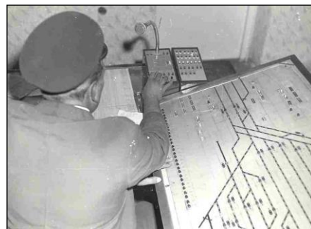
3. kép KAB, Kétirányú asztali bemozdó az IntegraDomino pult mellett
