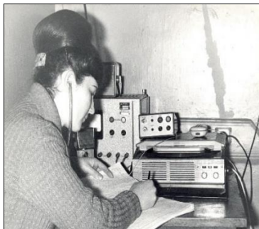
3. kép Rádióval vett kocsiadatok beírása és magnetofonra való rögzítése
