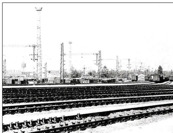
1. kép Az osztrák ELIN cég Dowty-rendszerű fékező elemekkel felszerelt vágányok
