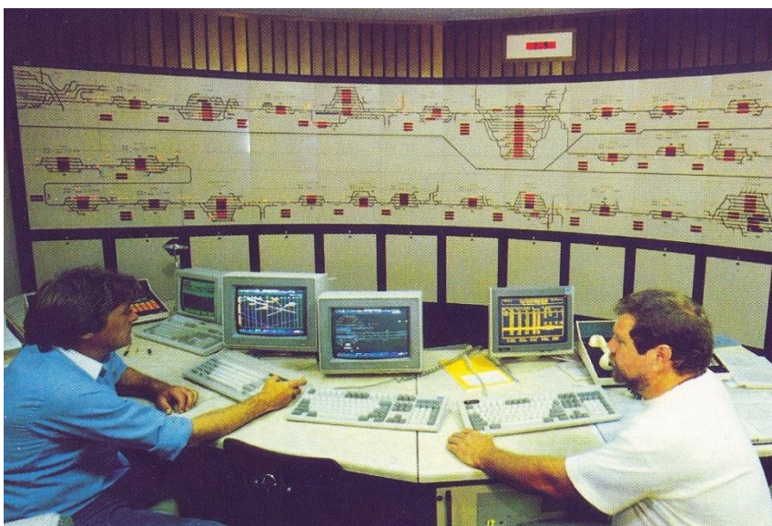
2. kép Taksony-Kelebia vonalszakasz, MMG-féle, KÖFE-berendezésének vágánytáblája és kezelőkészlete Szegeden [SÁ]
