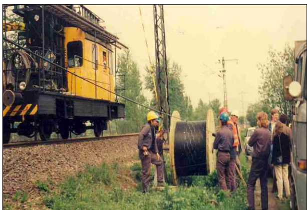
1. kép A kábel lehúzása a dobrol
