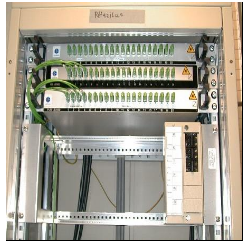
5. kép Optikai kábelrendező Rétszilason [CsCs]
