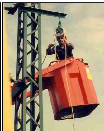
3. kép A kábel görgőbe akasztása
