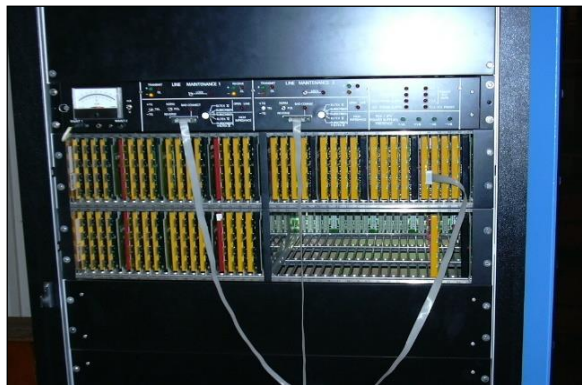
8. kép A SAGEM távgépiró központ befigyelő- és mérő-sávjai és alattuk az előfizetői sávok
