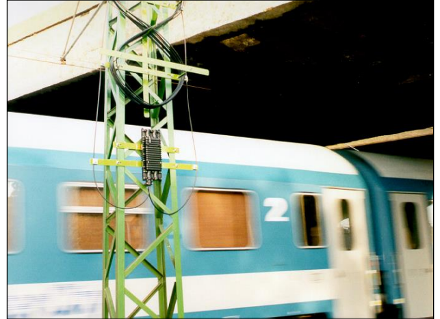
1. kép Optikai kábel kötődoboz és tartákolása [CsCs]
