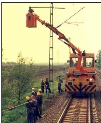
2. kép A kábel húzása
