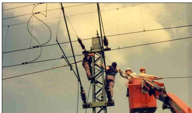
4. kép Fitel-féle optikai kábel végfeszítése oszlopon lévő kötődobozhoz
