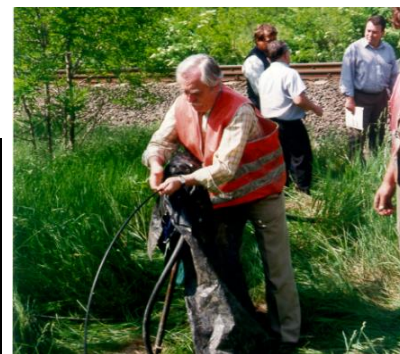
3. kép A kábel úsztatása a csőhálózatba [CsCs]
