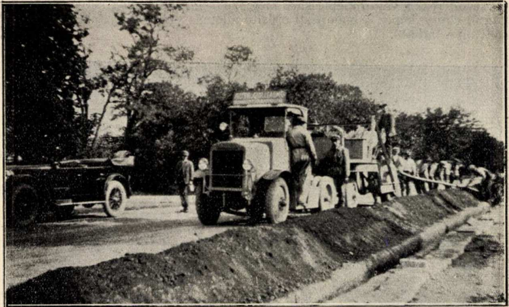
6. ábra. A kábel lefejtése és elhelyezése.
