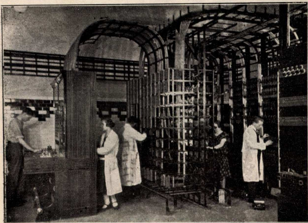
5. ábra. A budapesti erősítő állomás vizsgáló asztala és rendező állványa.
