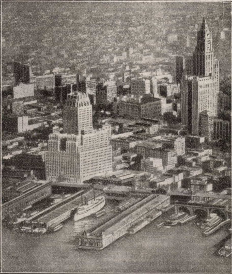
3. ábra. A New-York Telephone Co. épülete (az előérben) és közvetlen környéke.
