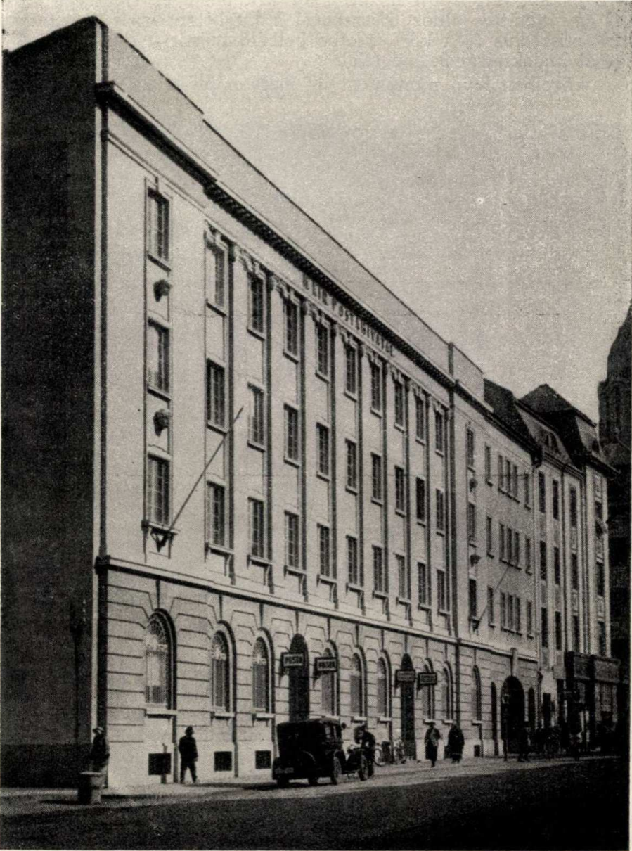
2. ábra. A debreceni postapalota Hatvan-utcai homlokzata.
