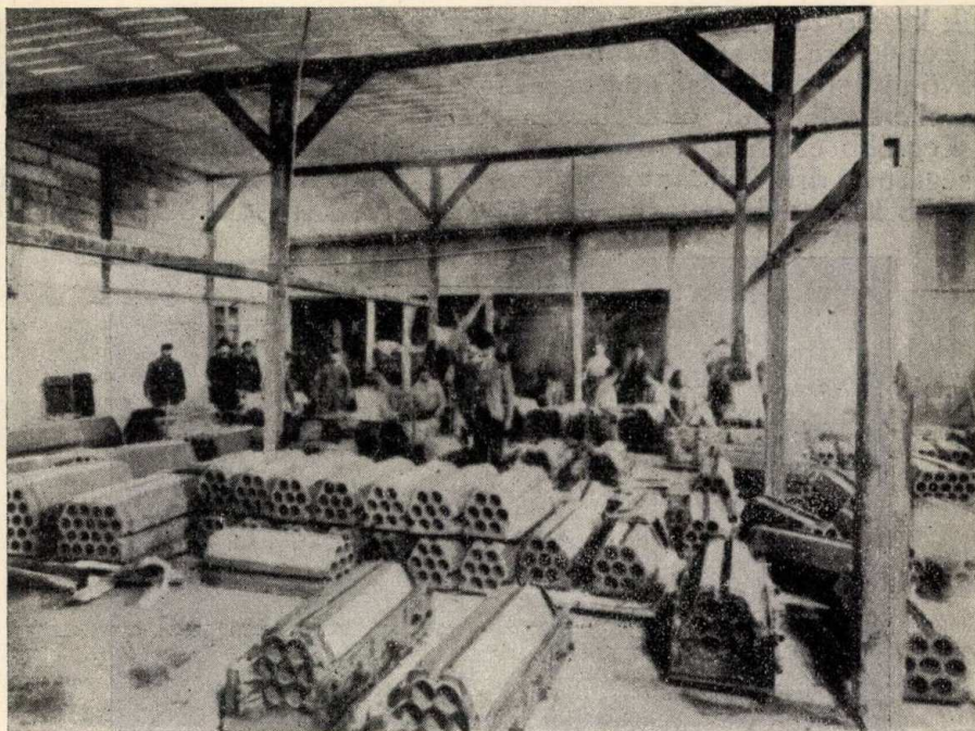
10. áb a. Különböző típusú kábeltömbcsatornák.
