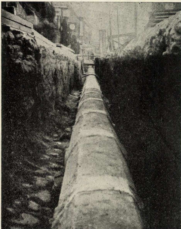
12. ábra. Kész kábeltömbesatorna beföldelés előtt.
