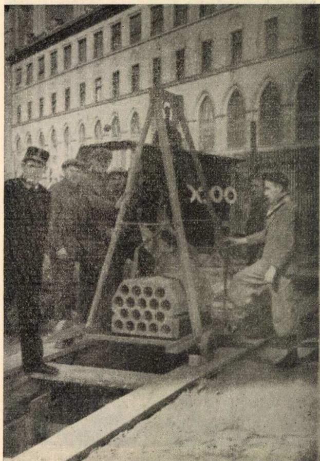
14. ábra. A 18 csatornás betontömb, leeresztésre készen.
