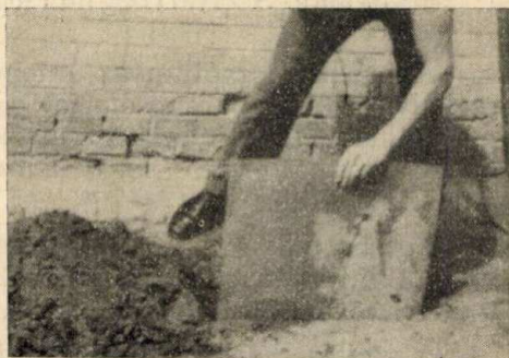
7. ábra Jó földelés készítése rézlemezzel.
