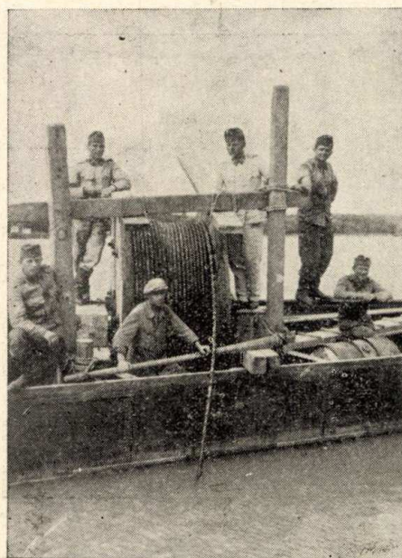
10. ábra. Folyamkábelek fektetése.
