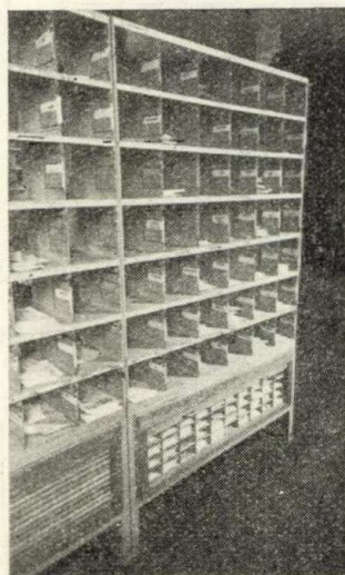
6. kép: A beosztószekrény hátoldala az indításjelzőkkel és a kötegelzőszekrényvel.
