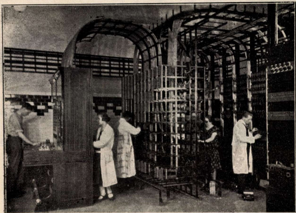
5. ábra. A budapesti erősítő állomás vizsgáló asztala és rendező állványa.
