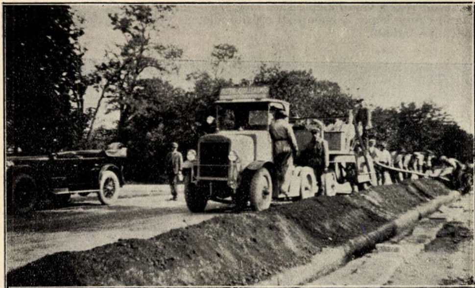
6. ábra. A kábel lefejtése és elhelyezése.
