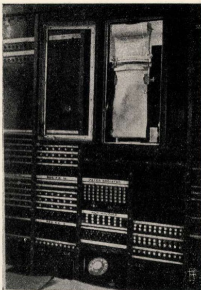
8. ábra. Forgalmi megfigyelő váltó kapcsolómezeje.
