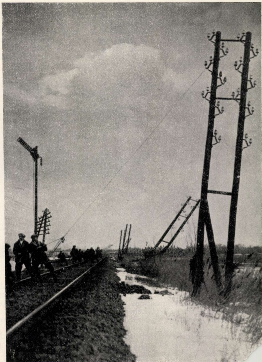
6. ábra. Hóvihar által kidöntött oszlopsor.
