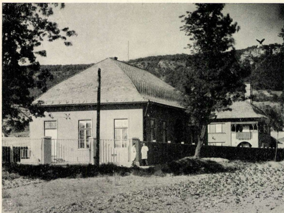
10. ábra. A bányahidai erősítő-állomás épülete. Tervezte: Bene Antal posta mérnök.
