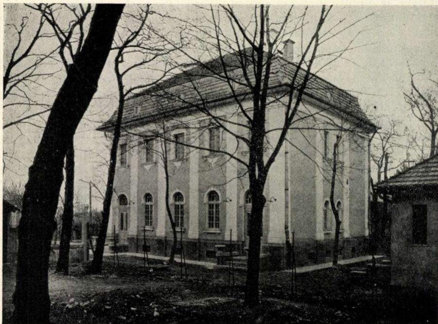
5. ábra. A „Svábhegy“ távbeszélő-központ épülete. Tervezte: Klucsik Vilmos posta segédmérnök.
