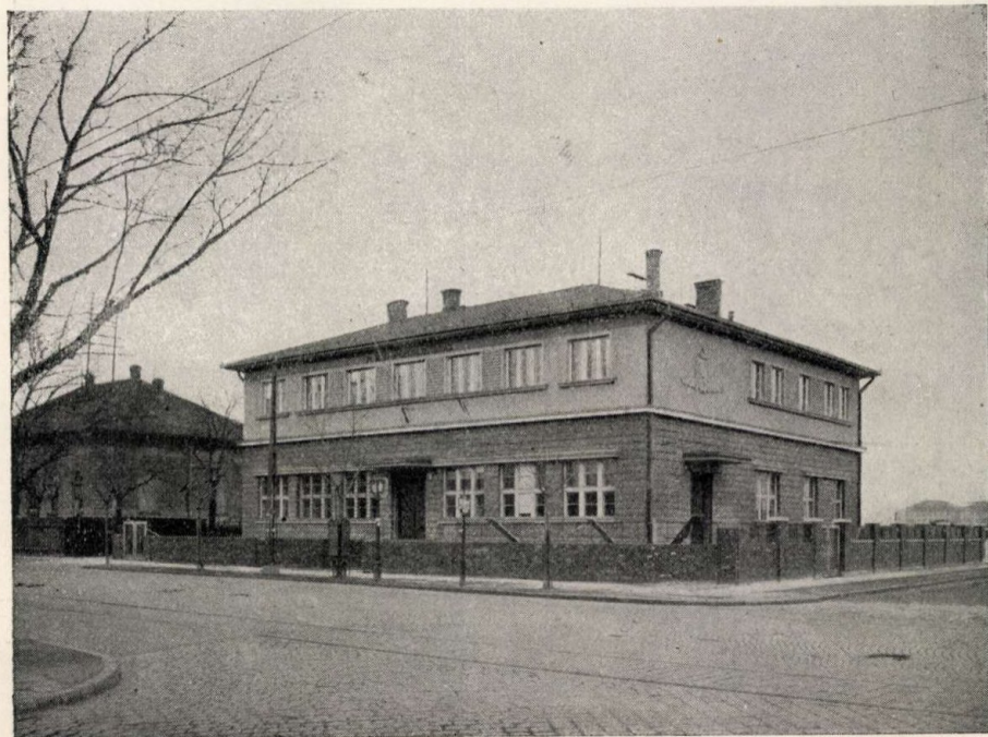
8. ábra. A „Zugló” automata-központ épülete. Tervezte: Klusik Vilmos posta segédmérnök.
