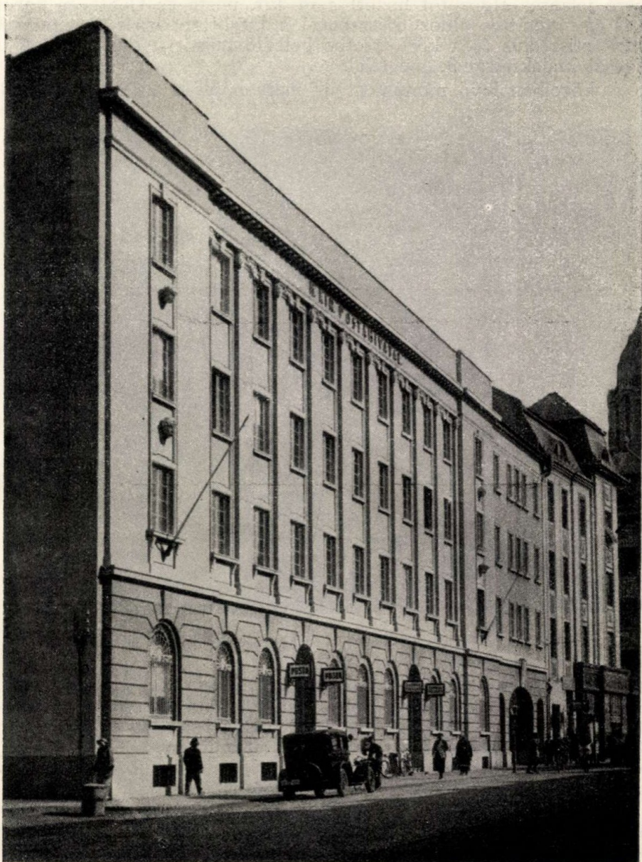
2. ábra. A debreceni postapalota Hatvan-utcai homlokzata.
