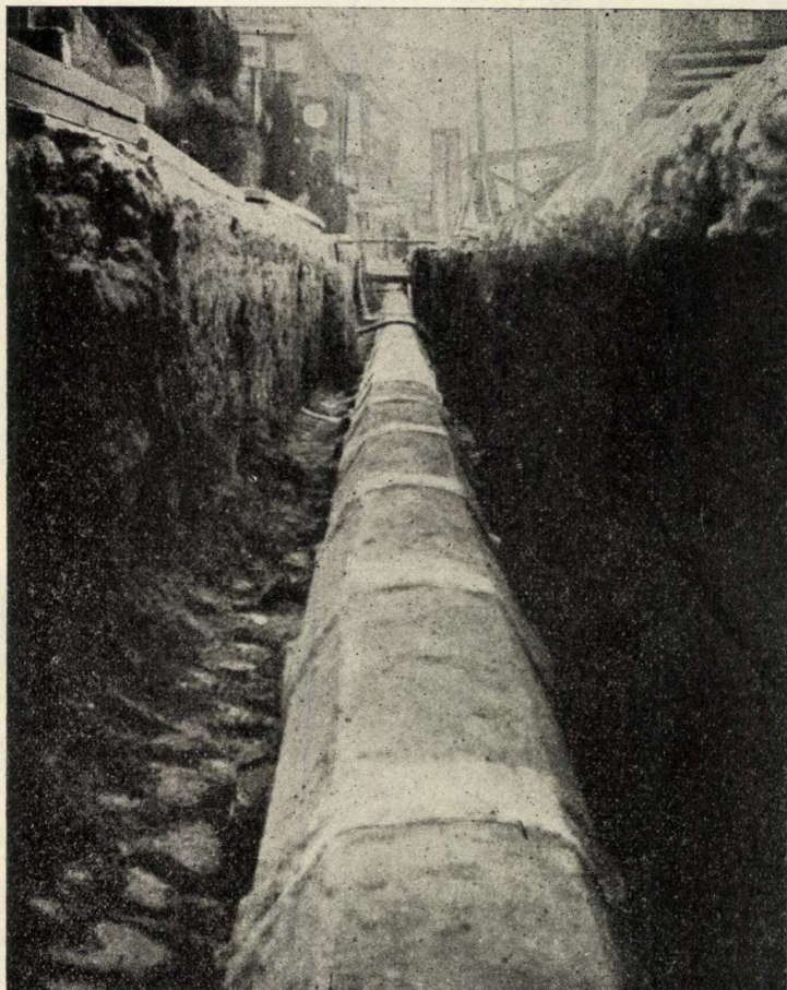
12. ábra. Kész kábeltömbesatorna beföldelés előtt.
