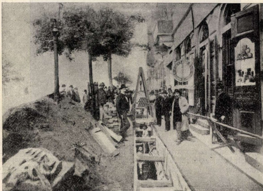
11. ábra. Kábeltömbcsatornák fektetése.
