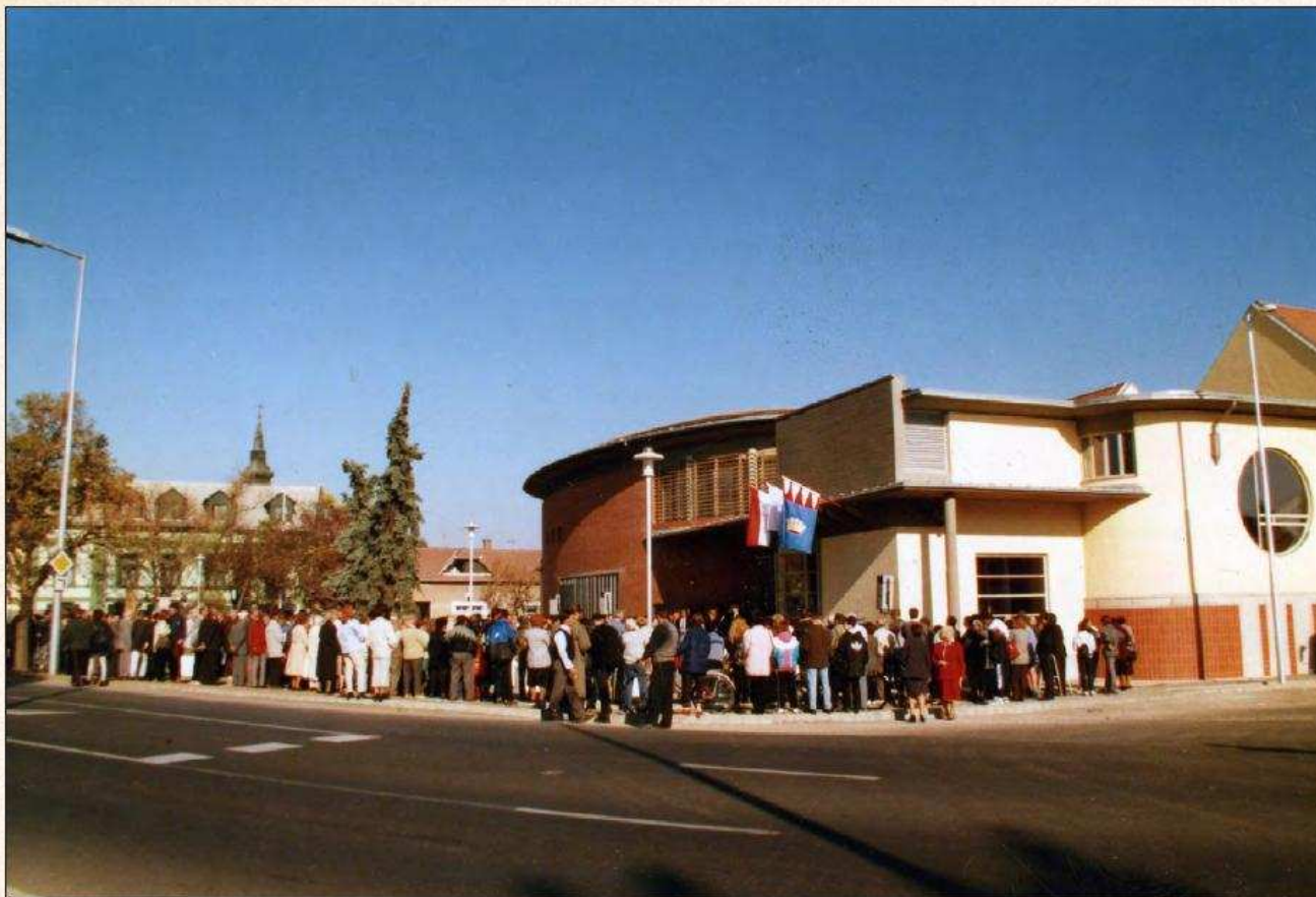
Az új, 2000-ben átadott postaépület hasznos alapterülete 1814,46 m 2 , 2000-ben Németh Mária vezetésével 94-en dolgoztak itt. Az épület tervezője Patartics Zorán pécsi építész, 2002-ben Gyula 1. posta tervezői munkájáért „Pro Architectura” díj elismerésben részesült.
