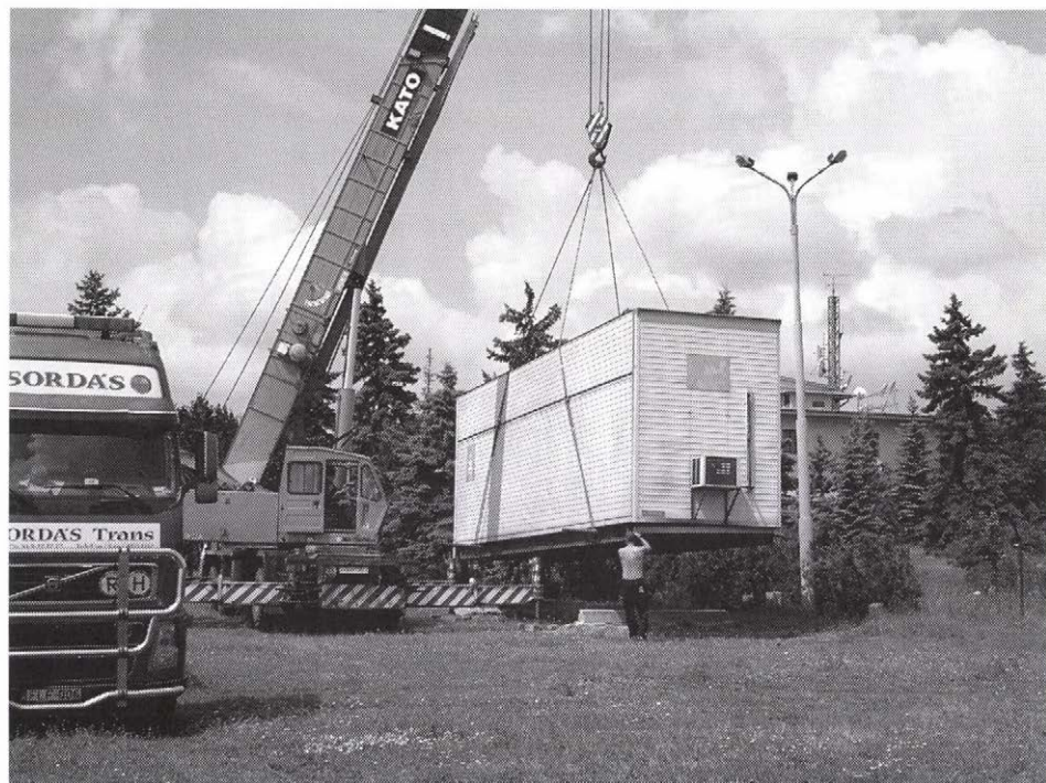
Az ARF 102 típusú konténerközpont lerakása Diósdon
