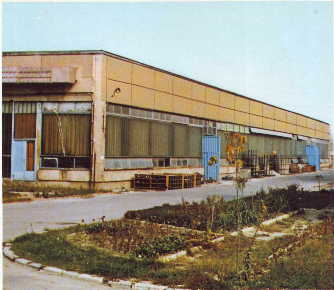
Üzemi épületek Tatabánya Platn – Tatabánya Betriebsgebäude; Tatabánya Цеховое здание. Татабánya
