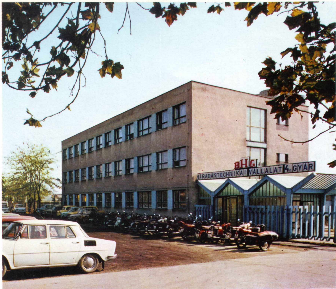
Igazgatási épület, Szekszárd Administrative building – Szekszárd Verwaltungsgebäude; Szekszárd Дирекционное здание. Сексард
