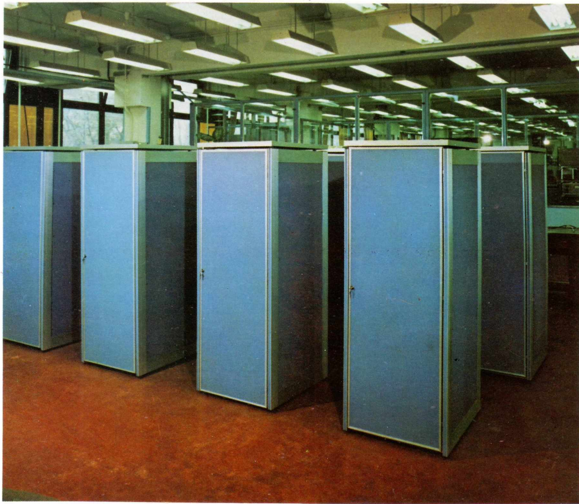
Elektronikus távbeszélő alközpontok Electronic telephone branch exchanges Elektronische Fernsprech- nebenstellenanlagen Электронная учрежденческая телефонная станция.
