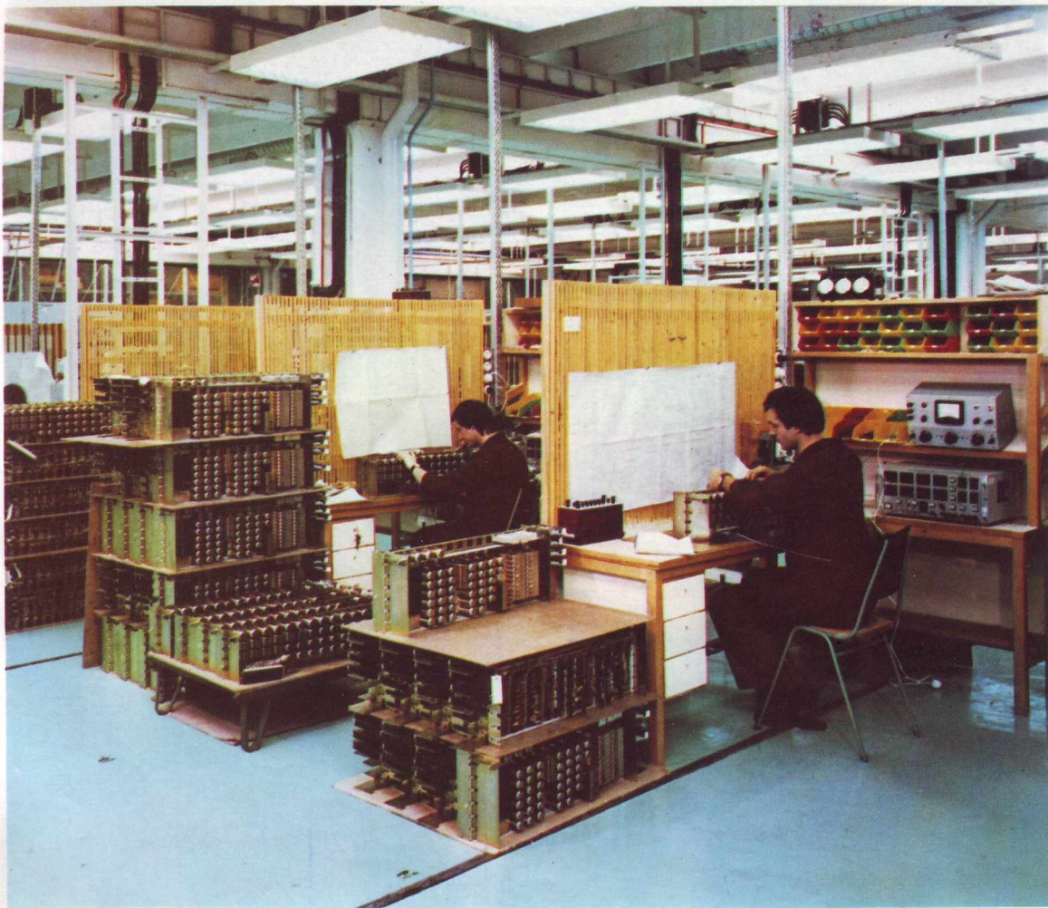
Műszeres beállítás jelfogó sávokon Instrumental lining-up on relay strips Instrumenteneinstellung an den Relaisstreifen Установка кабеля на релейных платах
