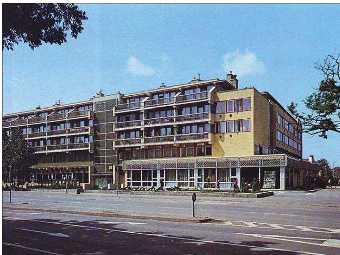
A Szabadság tér 1-3. szám alatti épület, amelyben a posta 1979-2004 között működött 43
