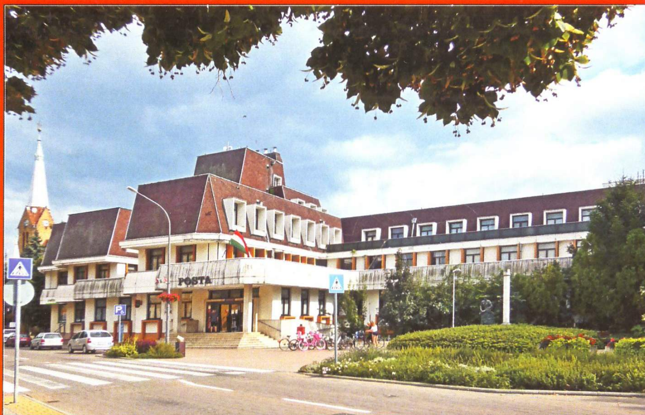
Állandó kiállításunknak helyet adó Szentés 1. sz. Posta épülete
