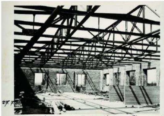
Eisenkonstruktion der Dachtr. über dem Bürogebäude
