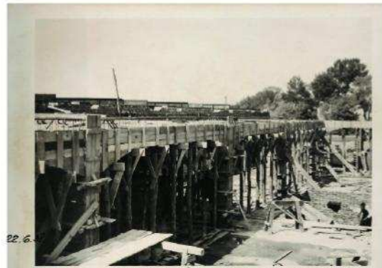
Schalung des Mittelbalkens in der Parterredeske.
