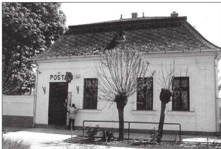
Az almáskamarási posta épülete
