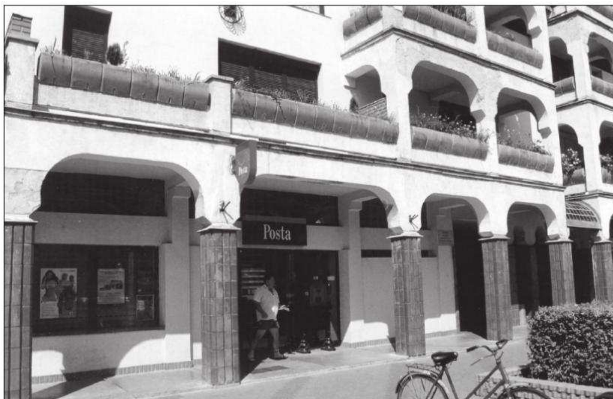
Mezőberény posta a Kossuth tér 12. számú ház földszintjén
