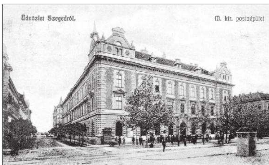
A szegedi nagyposta épülete
