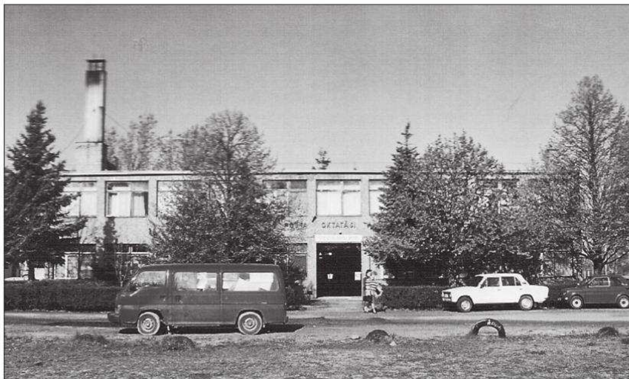
Az Oktatási Központ épülete
