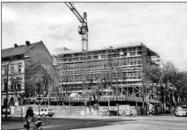
Az új igazgatási és műszaki épület kivitelezése, 1974. ápr. 19. (Postatörténeti gyűjtemény, Szentes)
