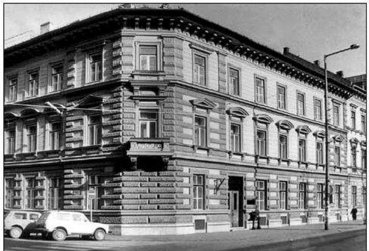
A postaigazgatóság Tisza L. krt. 43–45. sz. alatti épülete
