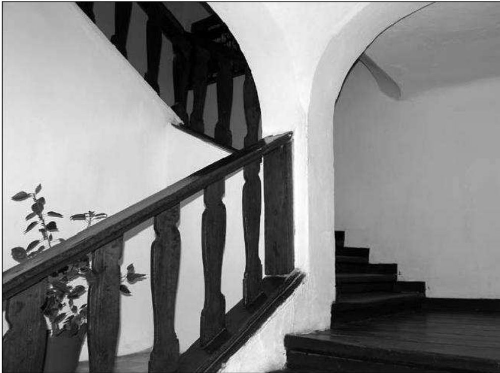
Az épület belső, eredeti lépcsője és korlátja (fotó: Ogrincs Pálné 2010)
