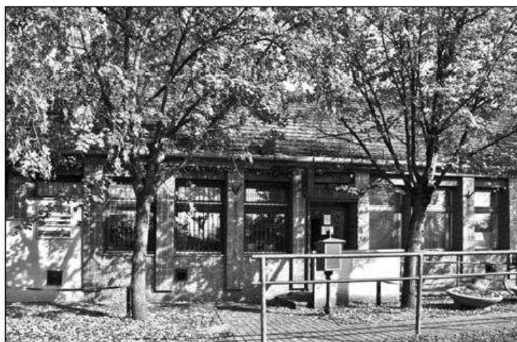
A 4. sz. posta épülete a Jókai út 58. szám alatt
