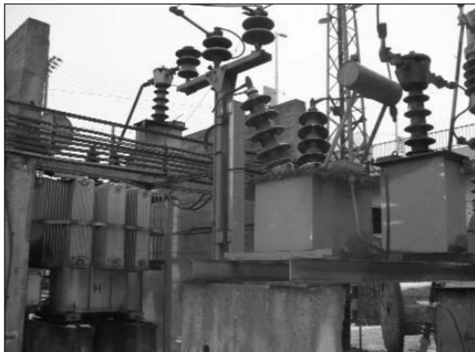
Kültéri előfűtő tr.állomás Bp. Nyugati pu.
