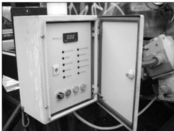
Vágánybakra szerelt helyi vezérlőszekrény
