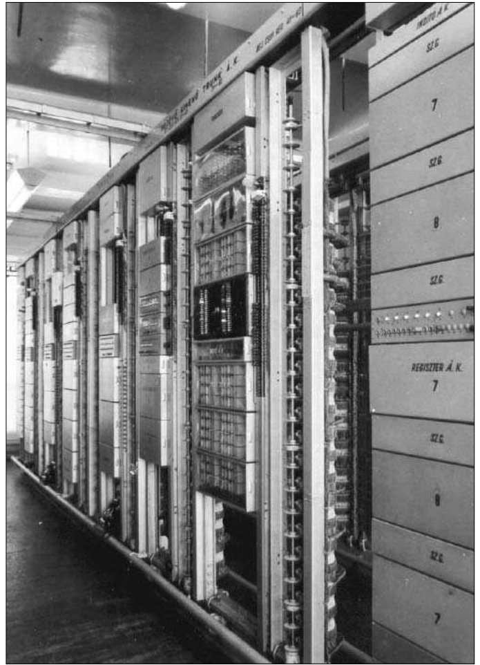
12–13. ábra: 2000 mellékes 7D-PBX központ Budapesten, a Horog utcában
