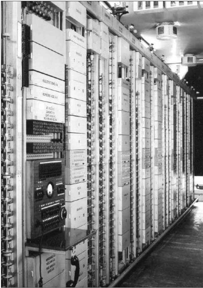
12–13. ábra: 2000 mellékes 7D-PBX központ Budapesten, a Horog utcában
